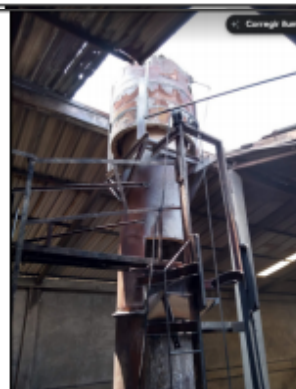
FOTO No. 6 TANQUE ENCIMA DEL HORNO
